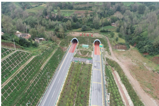
会川隧道进口绿化、排水沟
