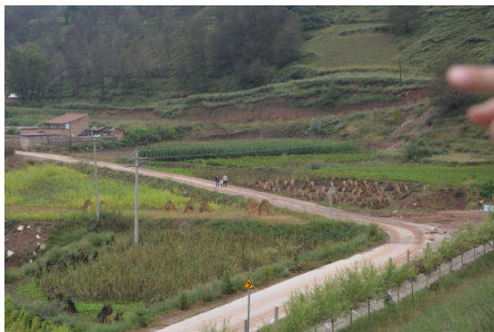
大临用地施工便道
