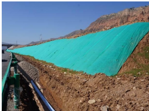
路基边坡临时苫盖和排水沟
