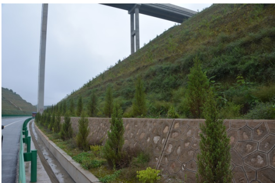
路堑边坡挂网植草防护
