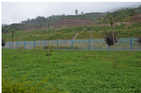
上湾服务区边坡绿化、排水沟
