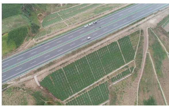
路堤框格网+植草防护
