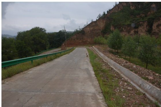
1#取土场施工便道
