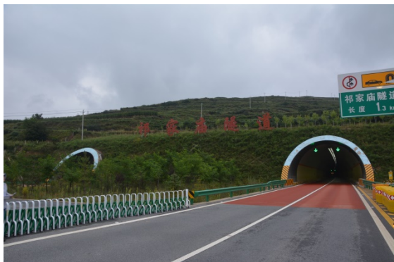
祁家庙隧道入口绿化、排水沟
