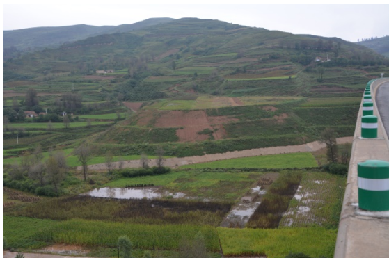
大临用地 (拌合场和钢筋场)
