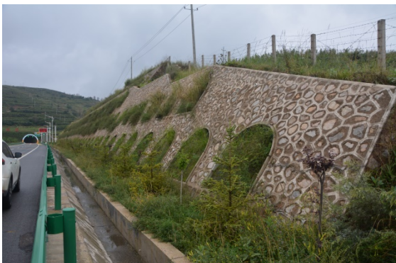
路堑孔窗式护面墙+植草防护
