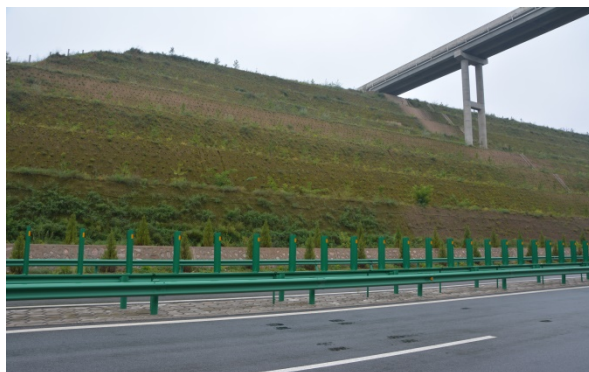
路堑边坡挂网植草防护
