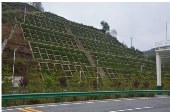
路堑边坡框格网+植草防护
