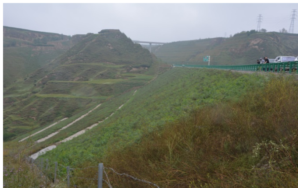
路堤植草防护
