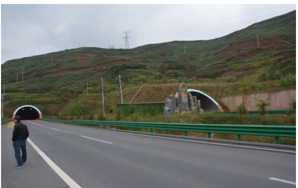
祁家庙隧道出口绿化、排水沟
